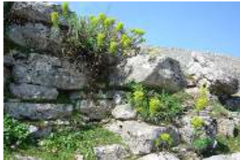
Figura 39 Mure të qytezës Dervene
