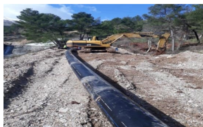
Rikonstruksion ujësjellësi në Përmet
