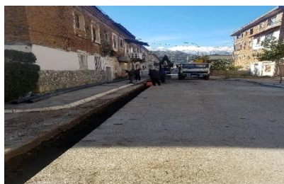
Rikonstruksion ujësjellësi në Memaliaj
